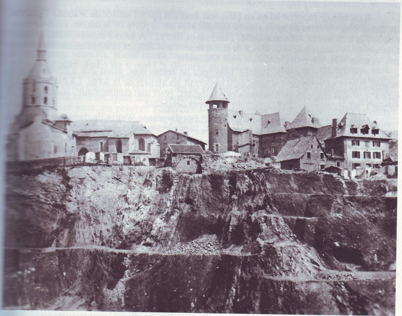
... l'effondrement. L'extraction du charbon à ciel ouvert a dévoré le sol jusqu'au pied des maisons et de l'église dont les fondations se trouvent dangereusement menacées.
